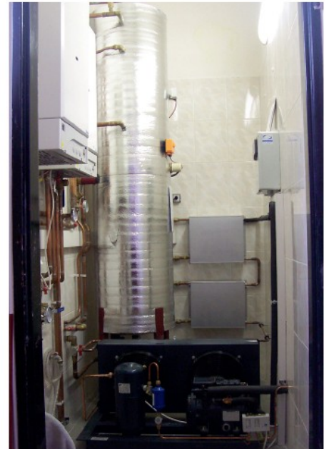
Paralelní propojení vždy dvou výměníků s nucenou cirkulací vody.
